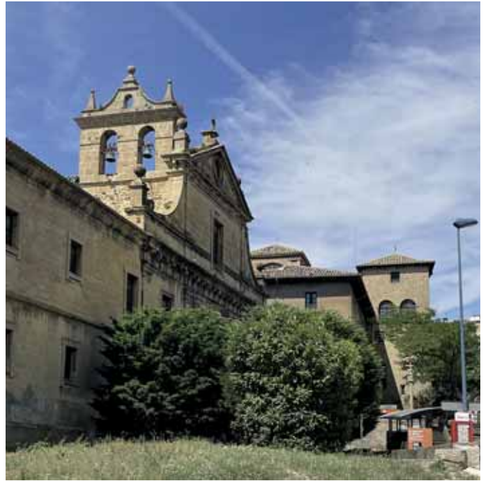
Le Couvent des Concepcionistas Recoletas (XVII ème siècle) relié au Palais conjoint par un arc monumental construit sur la route générale actuelle et faisant office de «porte» d'entrée de la ville.
