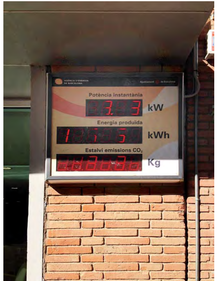
La façade équipée de panneaux solaires produit l'énergie de la bibliothèque (et du jardin)
